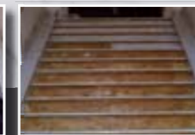
während der Arbeit
